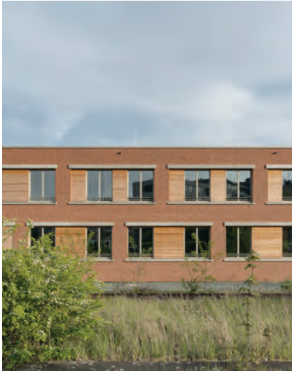
Nordseite zur Bahn
