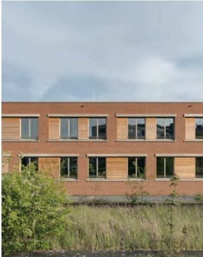
Nordseite zur Bahn
