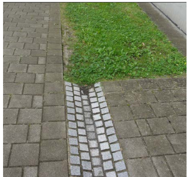
Einfache Maßnahme zur schadlosen Ableitung von Regenwasser
