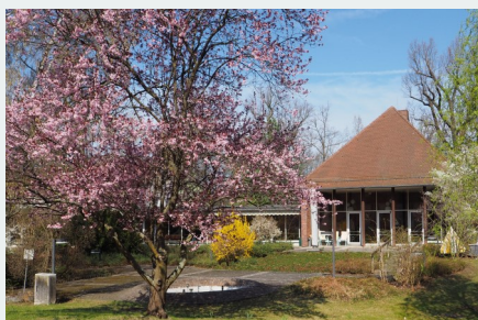
Senioren-Wohnanlage Platnersberg (Foto Ulrich Matz)
