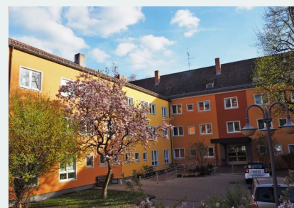
Senioren-Wohnanlage St. Johannis (Foto Ulrich Matz)
