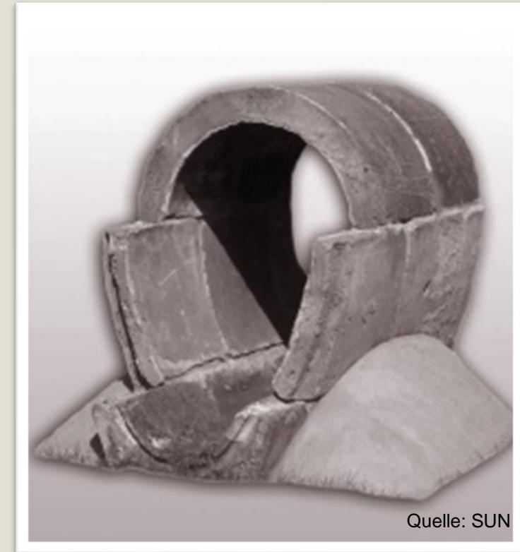
Vierteiliges Eiprofil 800/1200 aus Beton, wie es in Nürnberg von 1874 bis 1891 zum Einsatz kam.
