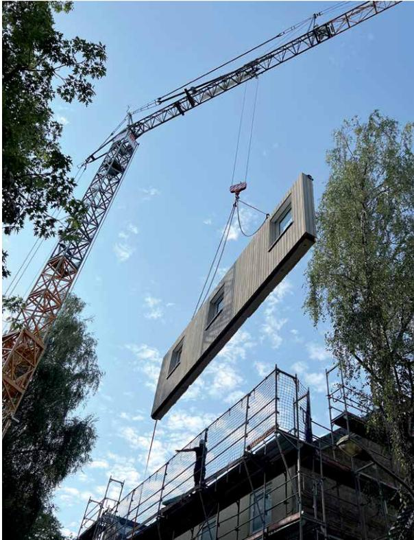
Fotomotive, siehe auch Titelbild: Die Fertigelemente werden an der Bestandsfassade befestigt.
