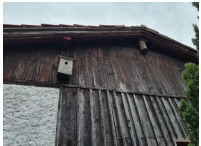
Foto 54: Nistkästen im Norden des Gebäudes C (8.9.22).
