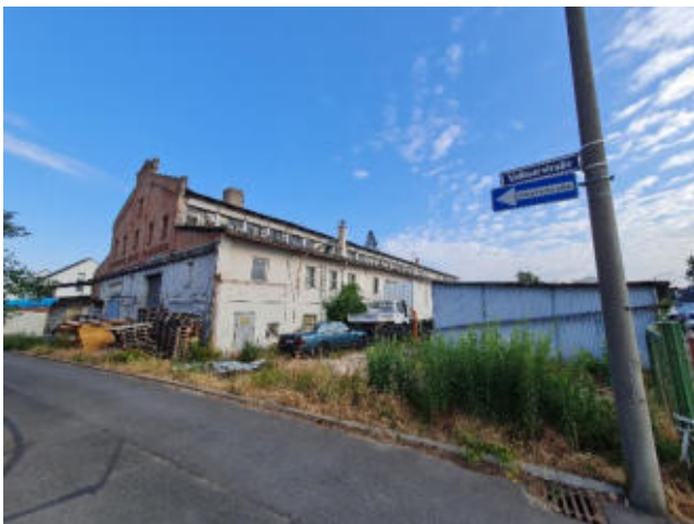
Foto 15: Gebäude G von Südosten (30.06.22).
