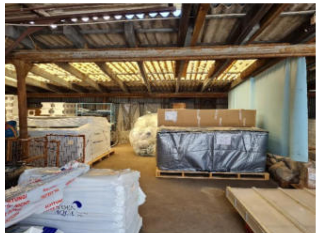
Foto 22: Schuppen / Lagerflächen (H) von Innen (30.6.22).
