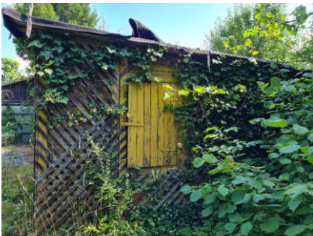
Foto 53: Anbau im Süden des Gebäudes C von Süden (30.6.22).
