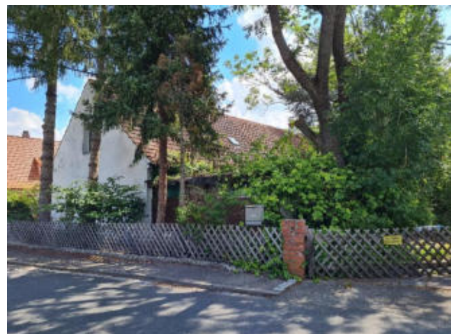
Foto 60: Gebäude D von Südwesten (30.6.22).
