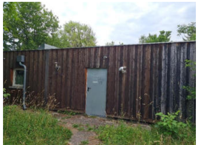
Foto 10: Blick von Süden auf Gebäude A (30.6.22).
