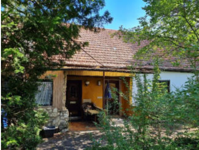
Foto 61: Gebäude D von Süden (30.6.22).
