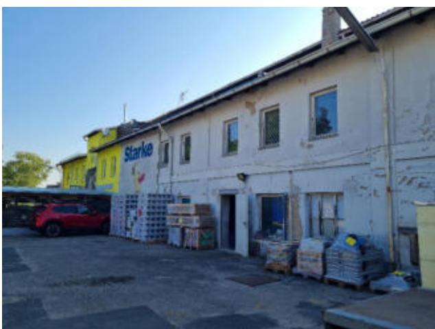
Foto 23: Gebäude (G) der Firma Starke von Westen. (30.06.22).
