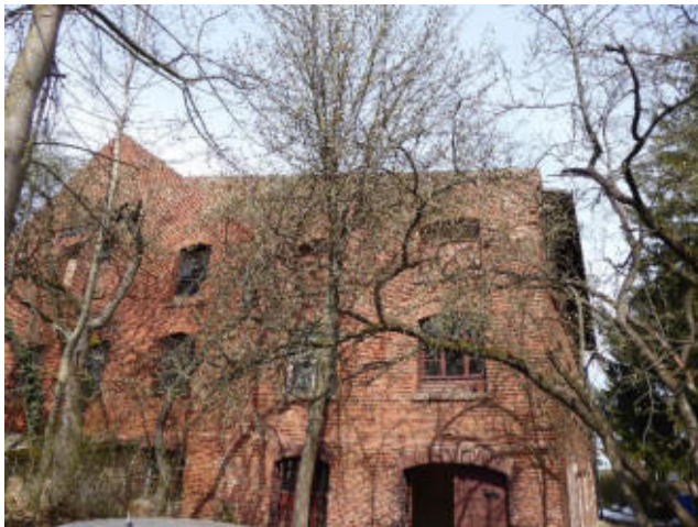
Foto 69: Gehölze vor Ziegelei im Süden (4.4.22).
