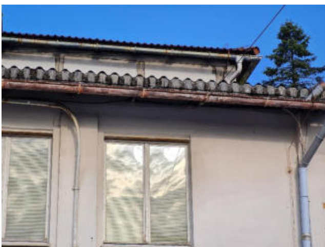
Foto 29: Oberer und unterer Traufbereich im Osten des Gebäudes (G) der Fa. Starke (30.6.22).
