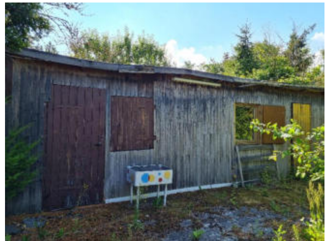
Foto 52: Anbau im Süden des Gebäudes C von Westen (30.6.22).
