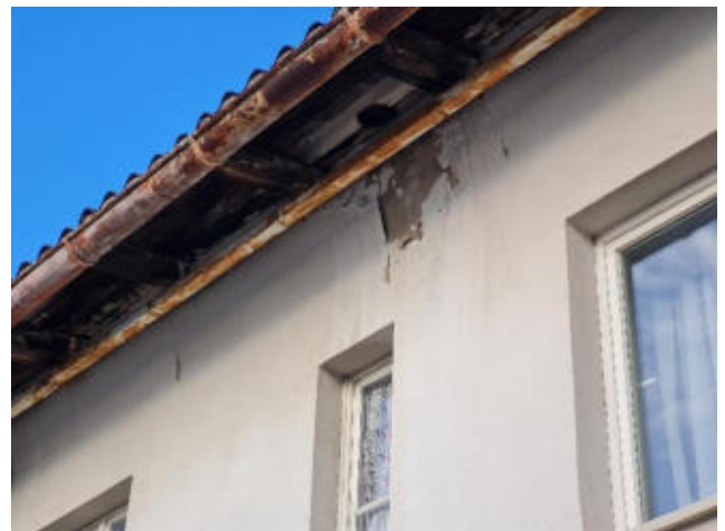
Foto 28: Östlicher Traufbereich von Gebäude (G) (30.6.22).
