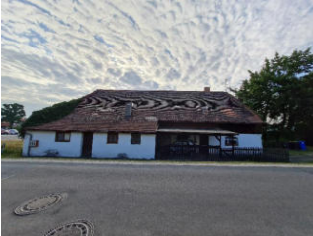
Foto 67: Alte Ziegelei von Westen (30.6.22).
