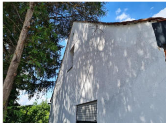
Foto 64: Gebäude D von Osten (30.6.22).
