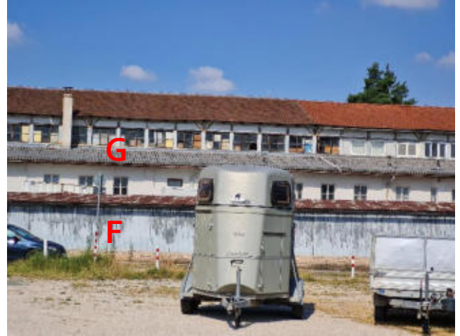
Foto 14: Blick auf die beiden Fassaden von Gebäude G und auf die Halle F (30.6.22).
