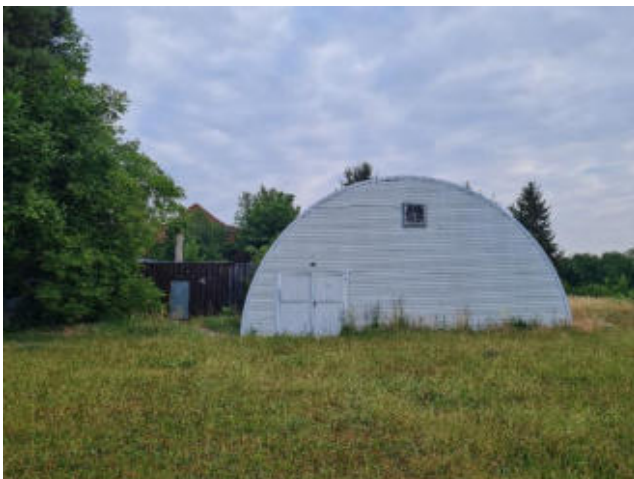
Foto 9: Blick von Süden auf die Schießhalle (Gebäude A) (30.6.22).
