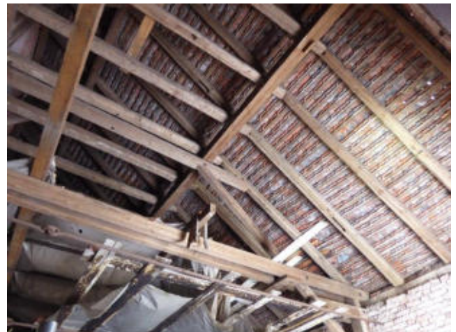
Foto 34: Dachboden des Gebäudes (G) der Fa. Starke (4.4.22).
