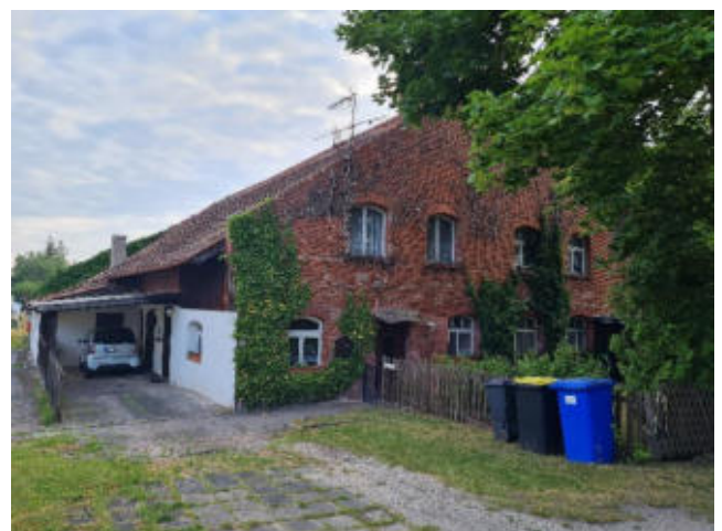
Foto 66: Alte Ziegelei (B) von Südwesten (30.6.22).
