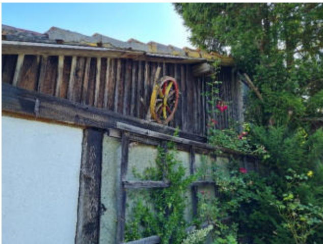
Foto 51: Südliche Fassade des Gebäudes C (30.6.22).
