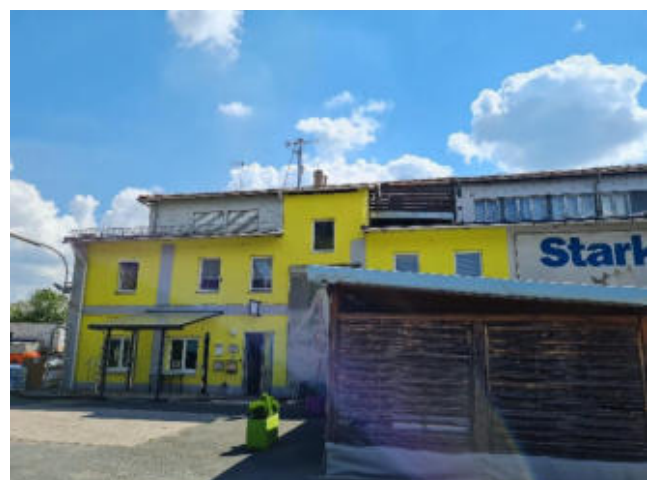
Foto 24: Gebäude (G) der Firma Starke von Westen (30.06.22).
