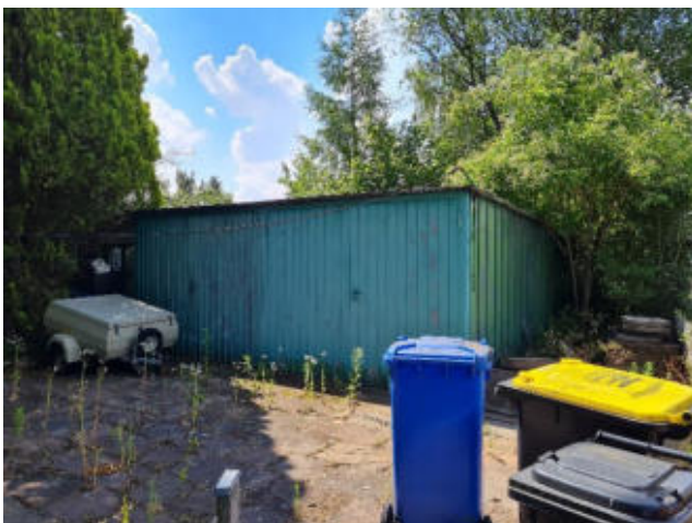
Foto 59: Garage südlich des Gebäudes D (30.6.22).
