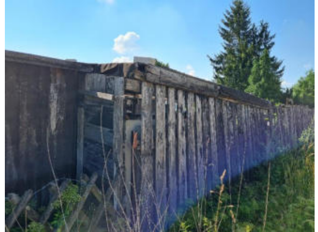
Foto 56: Detailsaufnahme des Holzschuppens westlich des Gebäudes C (30.6.22).
