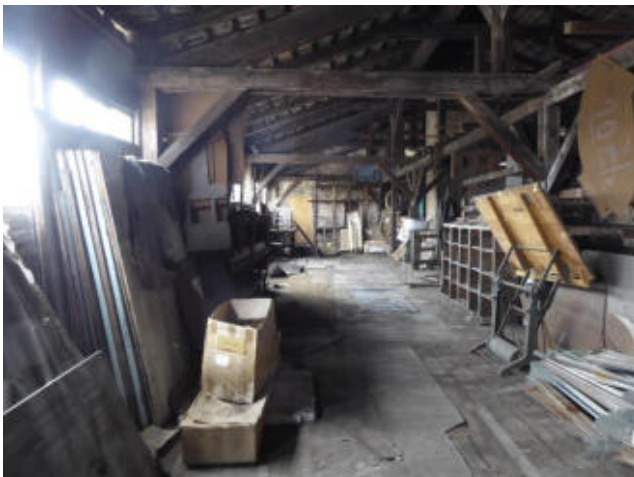
Foto 33: Dachboden des Gebäudes (G) der Fa. Starke (4.4.22).
