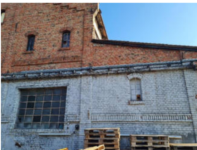
Foto 17: Detailaufnahme der südlichen Fassade des Gebäudes G (30.6.22).
