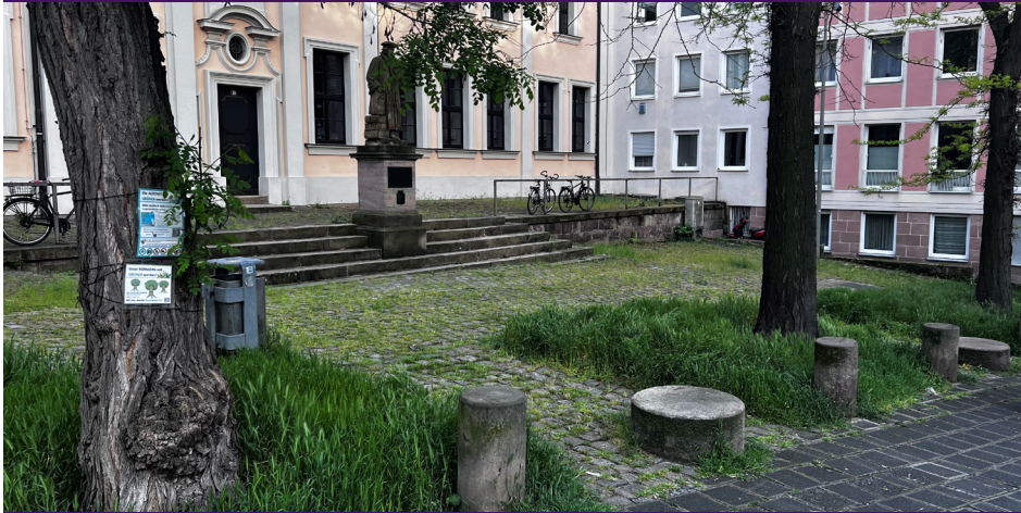
Abb. 3: Durchlässiger Pflasterbelag und Baumscheiben in Nürnberg
