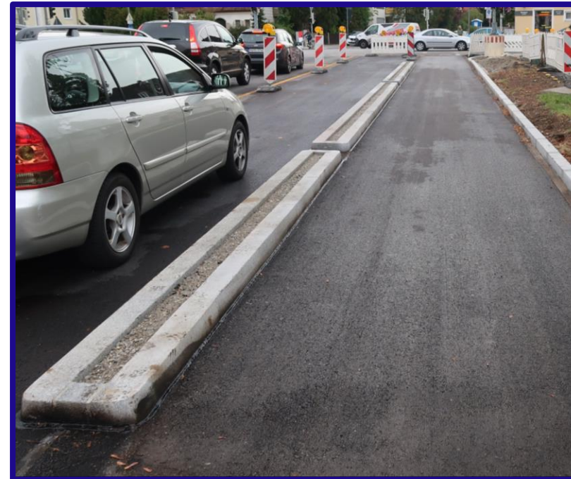
München, St.-Magnus-Straße, Radweg auf Fahrbahnniveau
